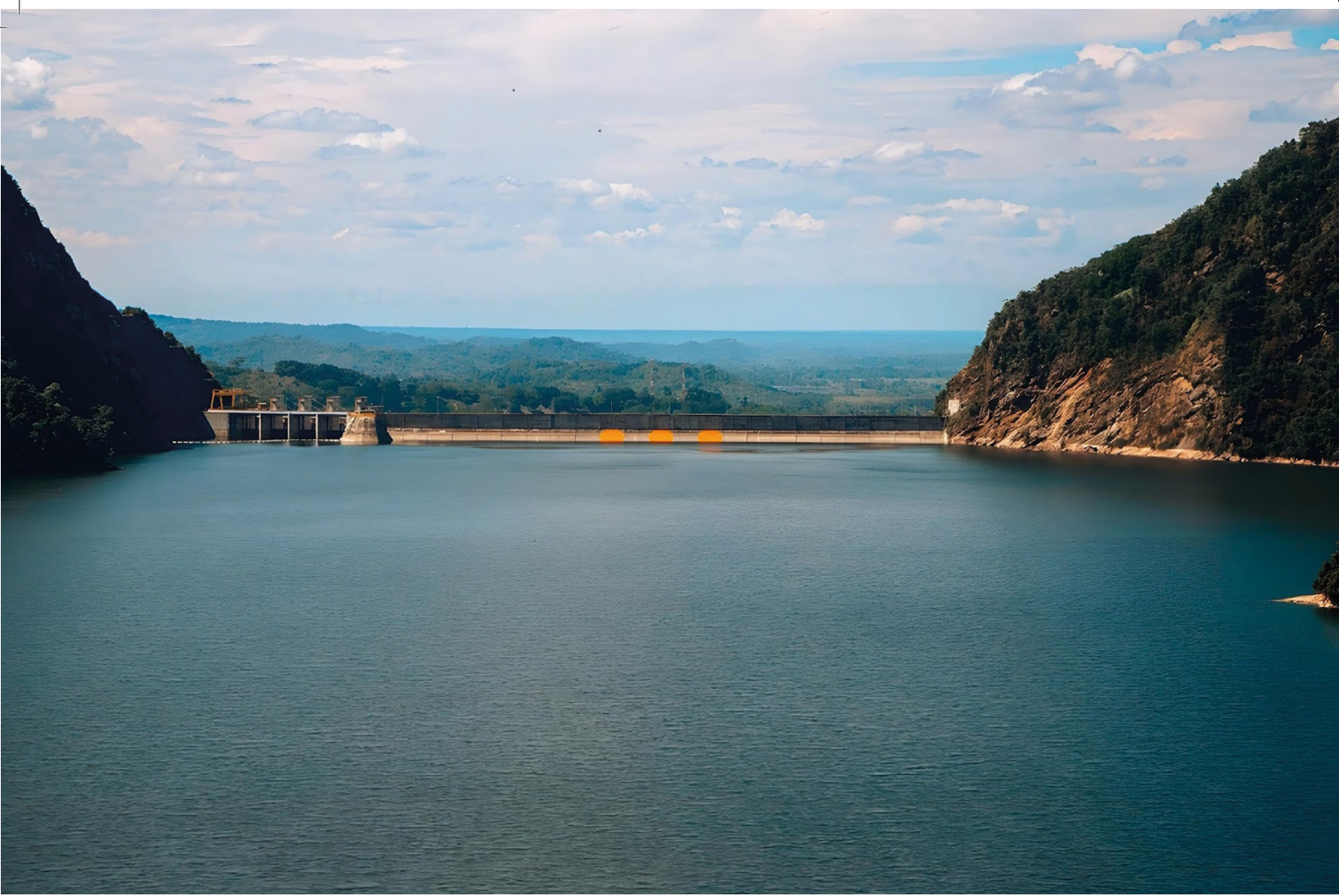
Represa de Hidrosogamoso
