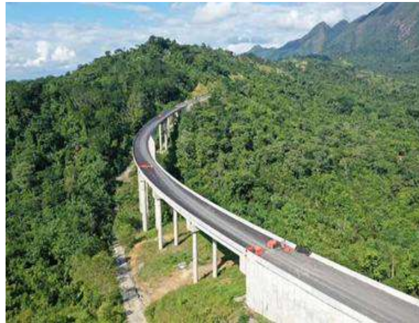
Viaducto La Peligrosa
