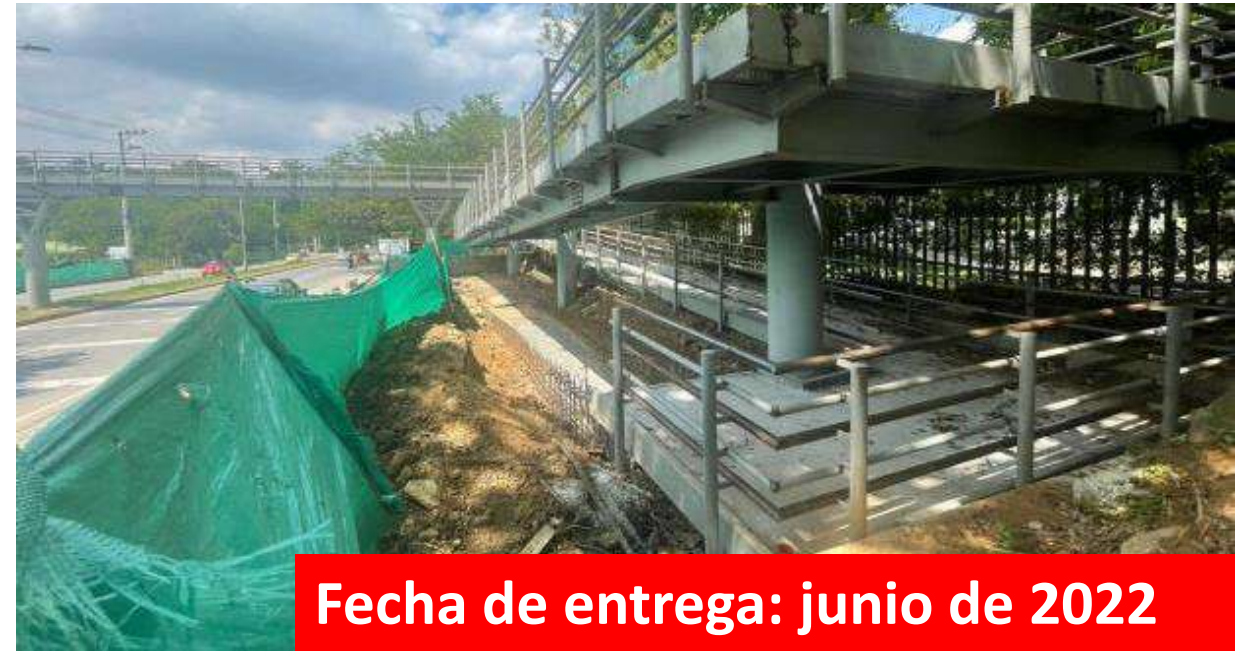
Puente Natura (67 % de avance)
