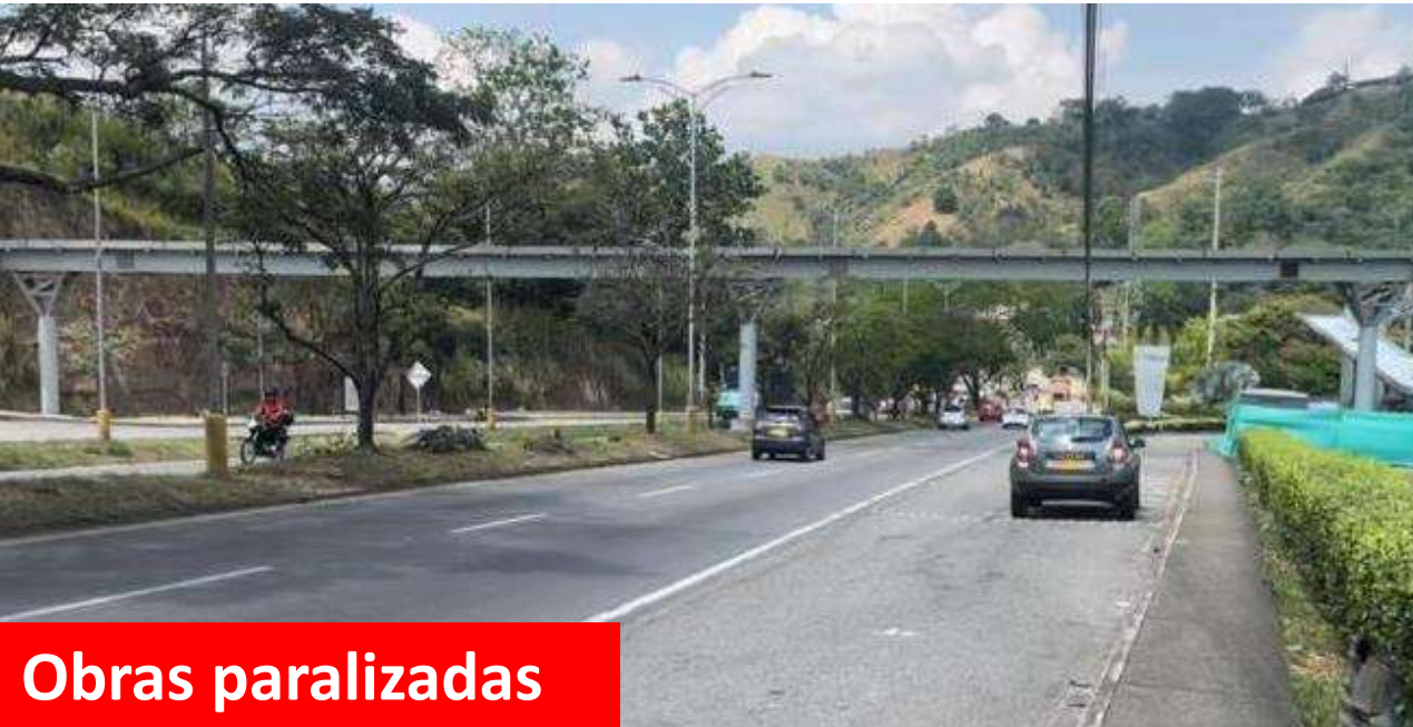
Puente Zona Franca (57% de avance)
