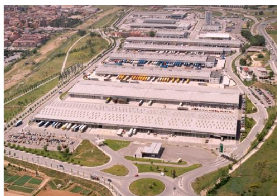
Figura 66. CIM VALLÉS – BARCELONA (ESP). Fuente: Elaboración propia con base en webs de infraestructuras, ACTE, Main Logistics Platforms, Europlatforms
