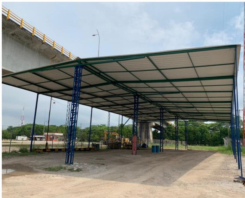
Figura 36. Área cubierta de almacenamiento Sociedad Portuaria de Barrancabermeja. Fuente: propia visita de campo
