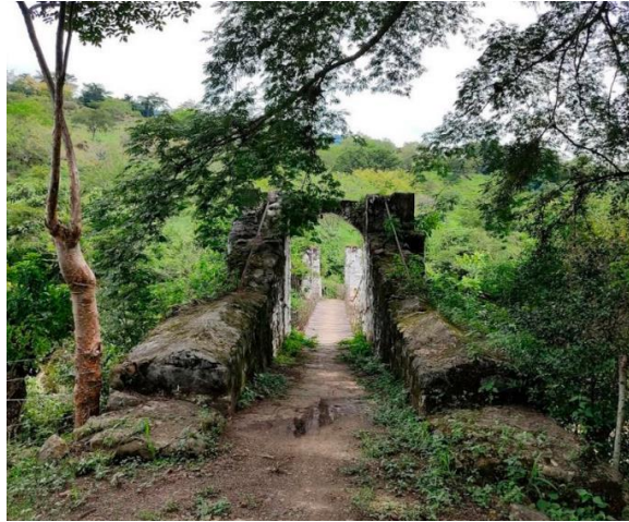
Figura 27. Imagen - Puente Sardinas - Rio Fonce
